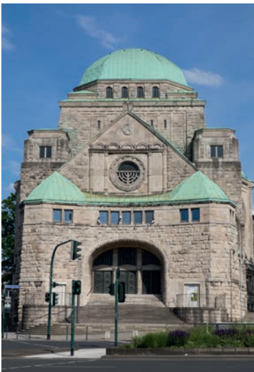
Die alte Synagoge in Essen. Vor einem Jahr schlugen vier Kugeln in die Tür des Rabbinerhauses ein. Die Spur führt in den Iran.
